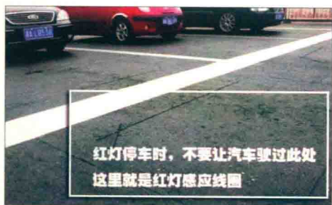
■ 图 16.1 停车线下埋有感应线圈
